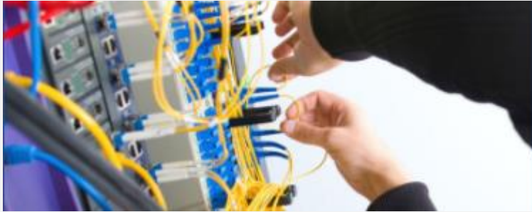
Монтаж ЛВС и сварка оптики
